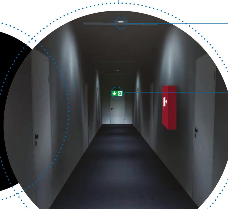
La iluminación de evacuación ilumina el suelo y ayuda a identificar los obstáculos y el equipo de seguridad. Ayuda a evitar el pánico asegurando una iluminación suficiente.
